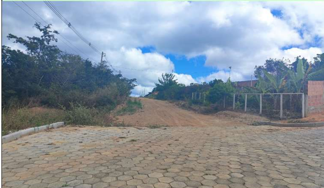
FOTO FINAL TRECHO DA AVENIDA
