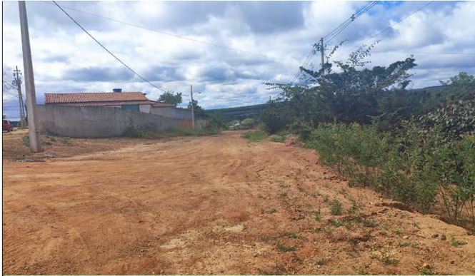
FOTO INÍCIO TRECHO DA AVENIDA
