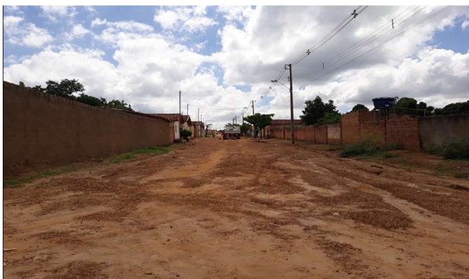
FOTO INÍCIO TRECHO DA RUA
