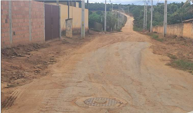
FOTO INÍCIO TRECHO DA RUA
