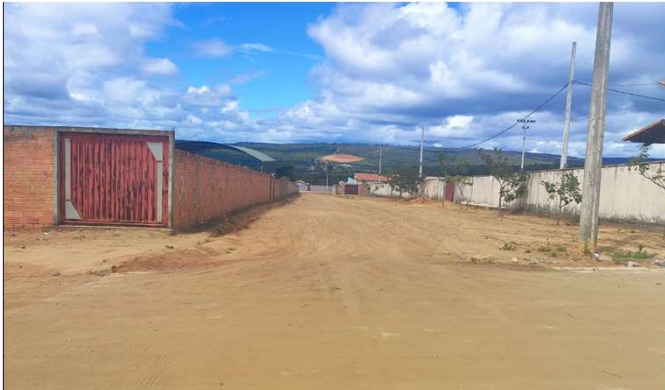
FOTO INÍCIO TRECHO DA RUA
